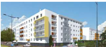
Résidence RAZIMBAUD - NARBONNE 2018
